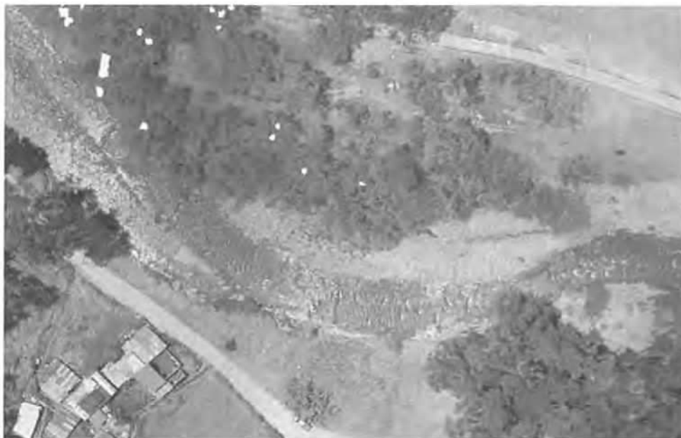
Foto Nro. 6 Socavación confinúa en Zona 5. Margen derecha, lado Oeste del área de estudio.
